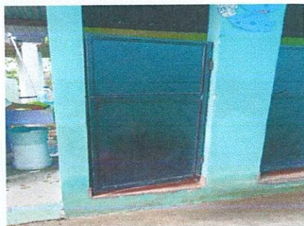
Foto 5: Mejoramiento de puertas de sanitario e instalación de azulejo.
